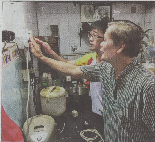
澳電電工協助梁先生辨認重新安裝插座的位置
